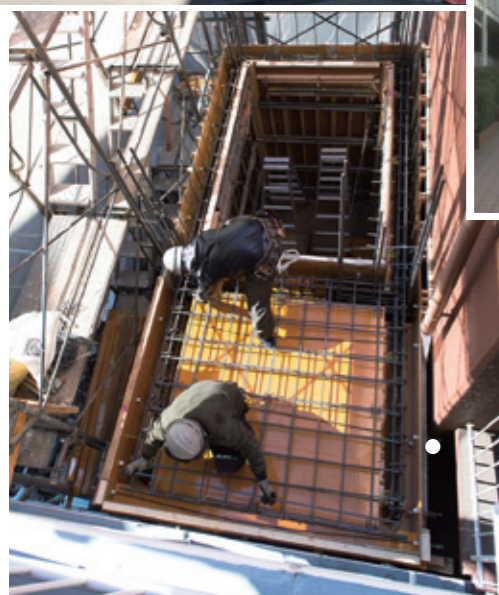
3坪ほどの敷地の上に9人乗り1機を動かすエレベーター室を設置する。地震で揺れても階段室と接触しないよう10cmの隙間を空けてある
