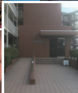
3坪ほどの敷地の上に9人乗り1機を動かすエレベーター室を設置する。地震で揺れても階段室と接触しないよう10cmの隙間を空けてある
